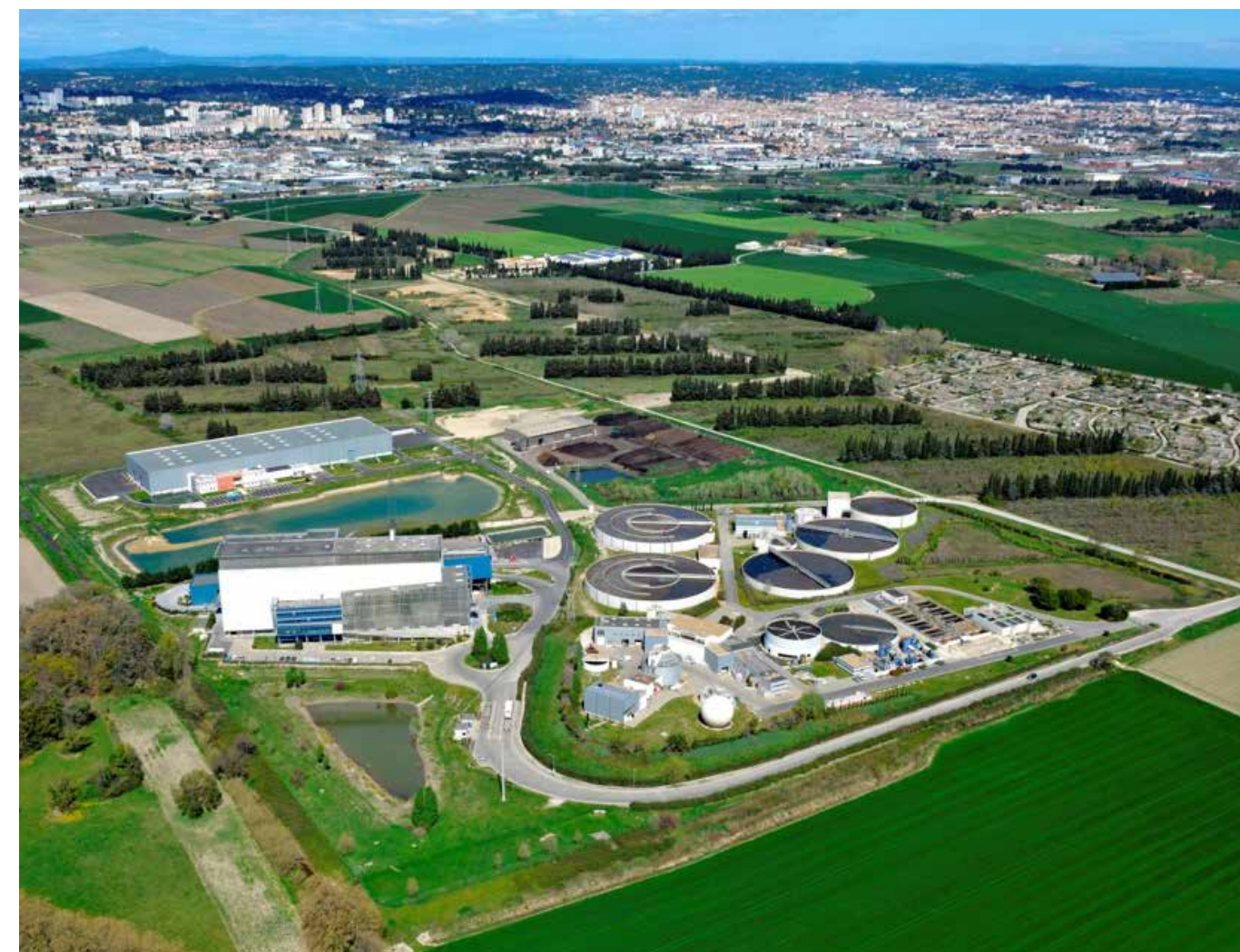
L'Eco-pôle de Nîmes Métropole rassemble l'usine d'incinération à valorisation énergétique Evolia, le Centre de tri Valréna, la station de traitement des eaux usées et la plateforme de compostage.
